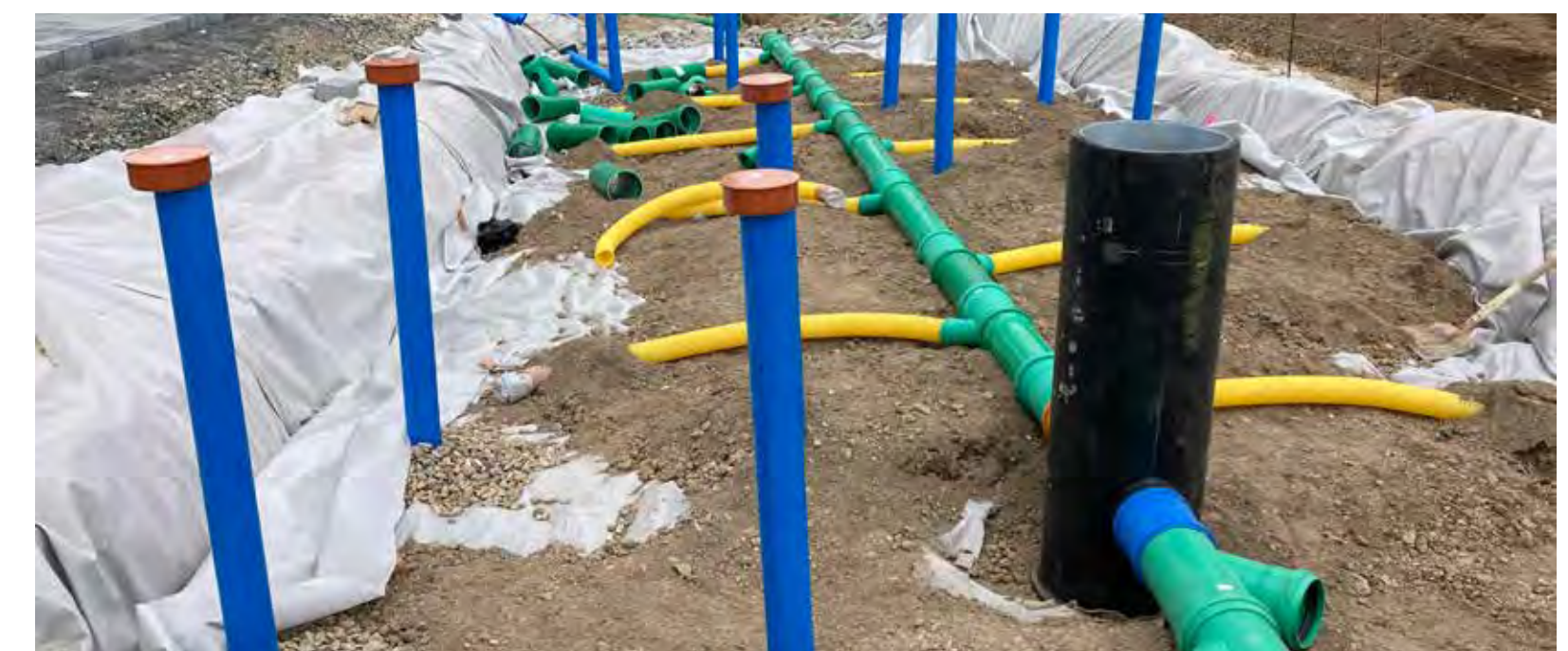
Einbau der Baumrigole im Hochbeet
