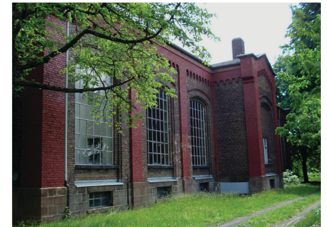
Abb. 1: Pumpstation Haan vor der Modernisierung
